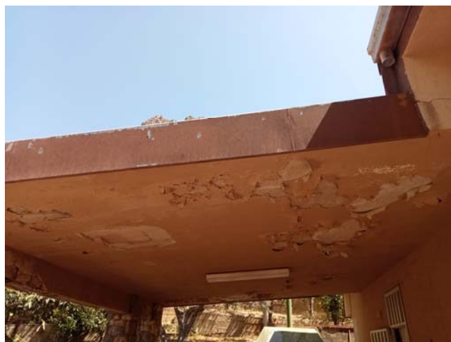
Foto z) portico (area oggetto d'intervento dei lavori di risanamento)
