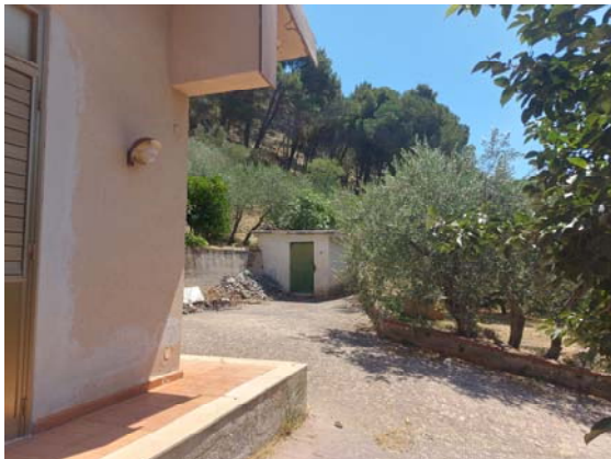
Foto h) vista verso est e locale deposito attrezzi
