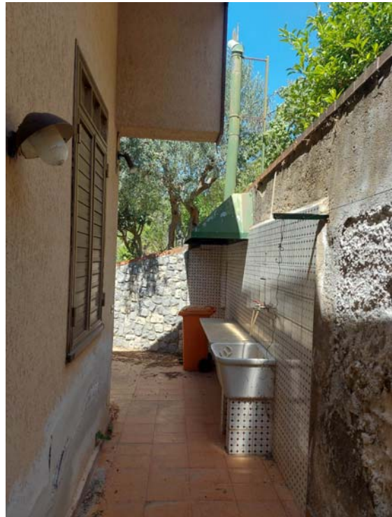
Foto o) vista retro-prospetto (lato nord)
