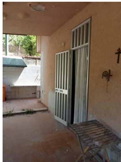
Foto k) prospetto ovest - portico con ingresso abitazione
