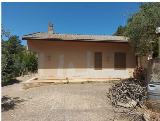
Foto j) prospetto est
