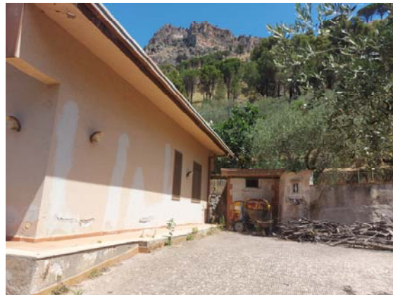
Foto i) prospetto est e locale doccia
