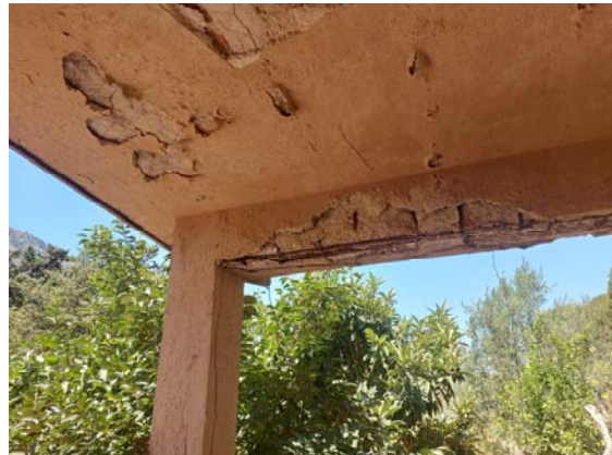
Foto u) portico (area oggetto d'intervento per i lavori di risanamento)
