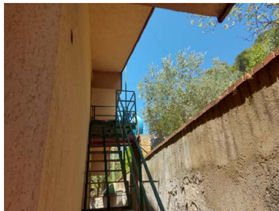
Foto q) scala del retro-prospetto per ispezione sottotetto
